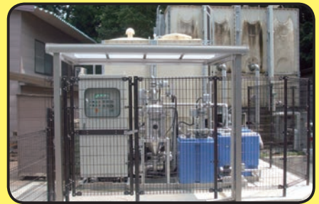
井水専用水道：8m 3 /hr モノMAXユニット350A
