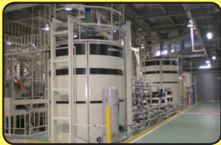
微細プラスチック洗浄水：12m 3 /hr モノMAXユニット500A
