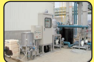
地下水（工業用）：10m 3 /hr モノMAXユニット600A
