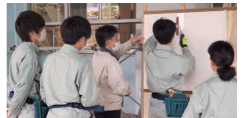
インテリア工事
