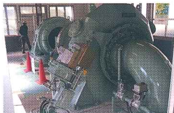
現地据付状態
