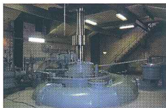
現地据付状態
